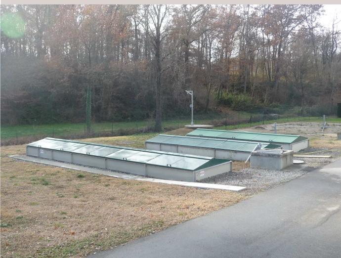
Ce système est évolutif, on peut rajouter plusieurs modules sur une surface réduite. Ces modules ont chacun une capacité d'épuration de 200 équivalent habitants.
